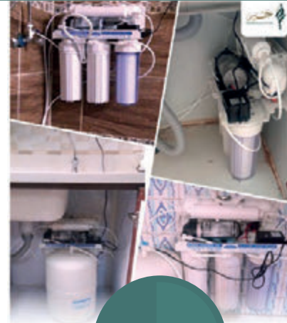
تركيب محطات تنقية المياه لـ 50 أسرة مستفيدة ضمن برنامج سقيا الماء
